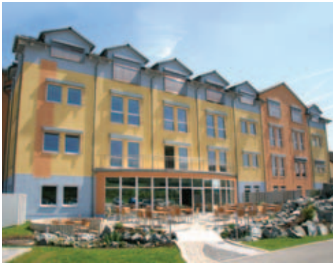
Eindrucksvoll vereint: GSD Softwareentwicklung, Schulungszentrum und stilvolles 4-Sterne Business- und Wellness-Hotel mit mediterranem Restaurant.
